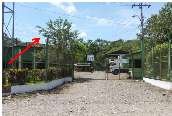
Ilustración 21 Sistema de alumbrado eléctrico.
